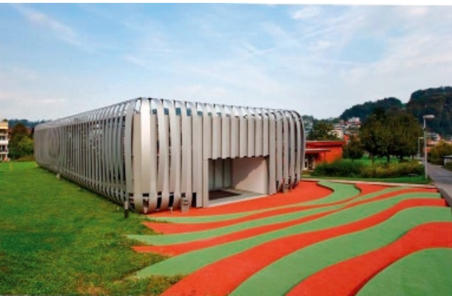
Das futuristische Gebäude des iHomeLab mit seiner Außenhaut aus beweglichen Lamellen prägt den Campus der Hochschule Luzern in Horw.
